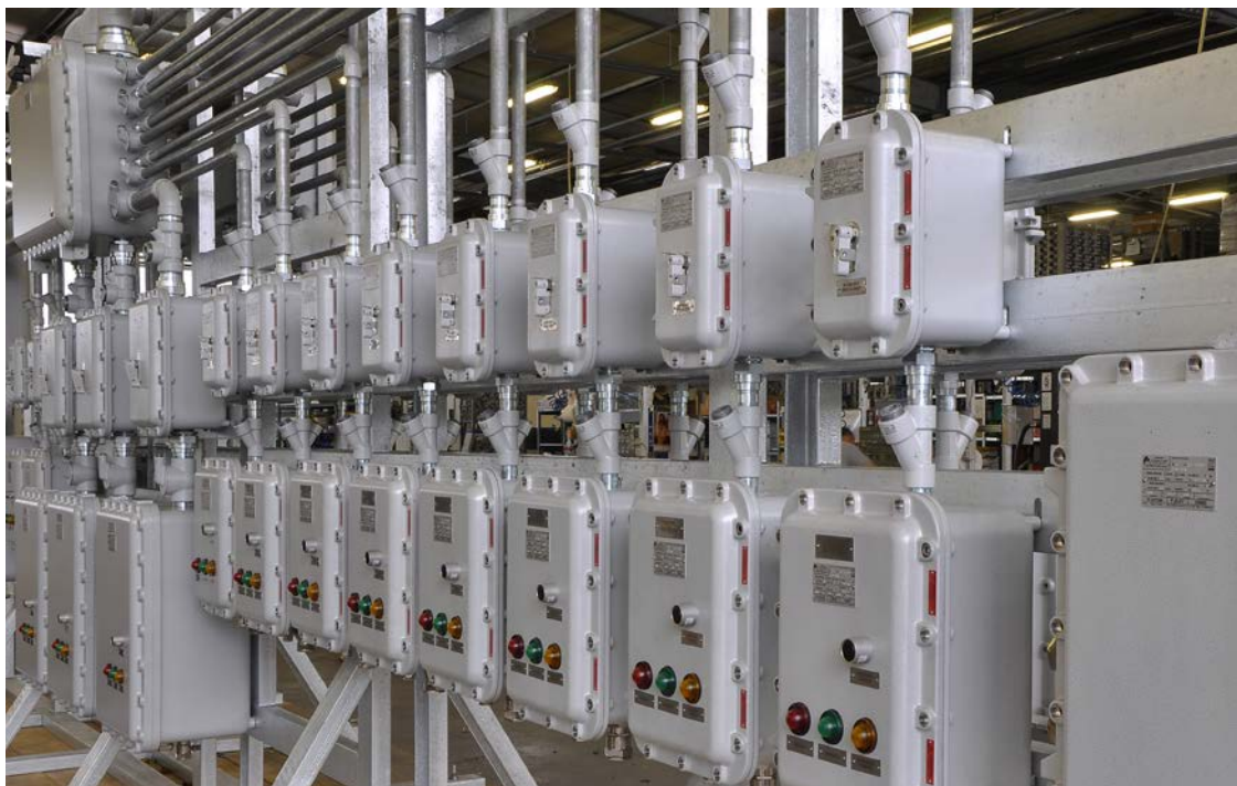
Fig. 16 Panel de control con instalación en doble frente, realizado según las especificaciones del cliente
