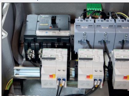
Interruptor automático de capa moldeada/ magnetotérmicos
