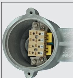
Entrata cavi direttamente alla morsettiere L, N, PE. Possibile entra-esce sez. max. 1.5 mm<sup>2</sup>. Ingresso 3 cavi singoli fino a 4mm<sup>2</sup>, ingresso entra-esce con 6 cavi singoli fino a 1,5mm<sup>2</sup>.
